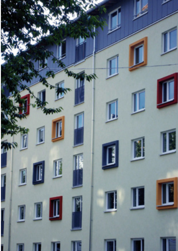
Abbildung 5: Demonstrationsprojekt „Lilienhof“ – energetisch sanierter Wohnblock der 50er Jahre in München
