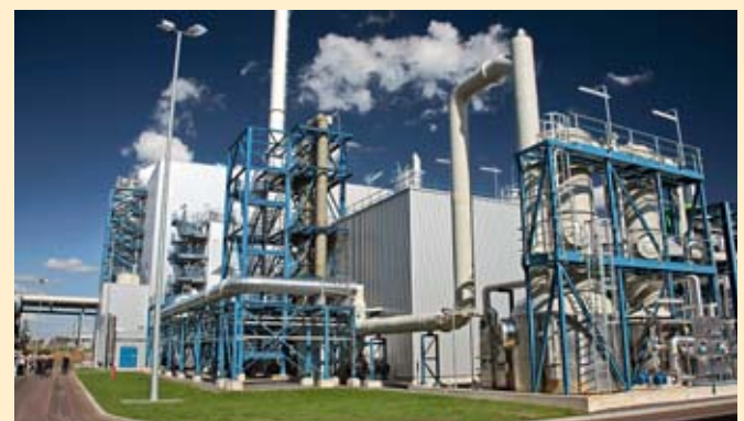
Abb. 32 Oxyfuel Pilotanlage am Standort Schwarze Pumpe. Foto: Vattenfall Europe AG
