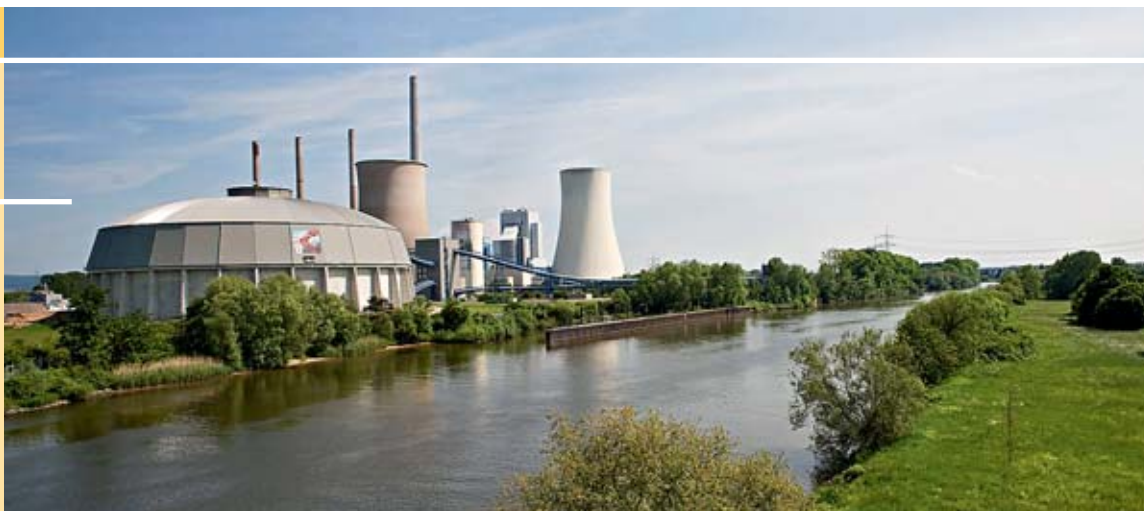
Abb. 8 Kraftwerk Staudinger. Foto: E.ON Kraftwerke GmbH
