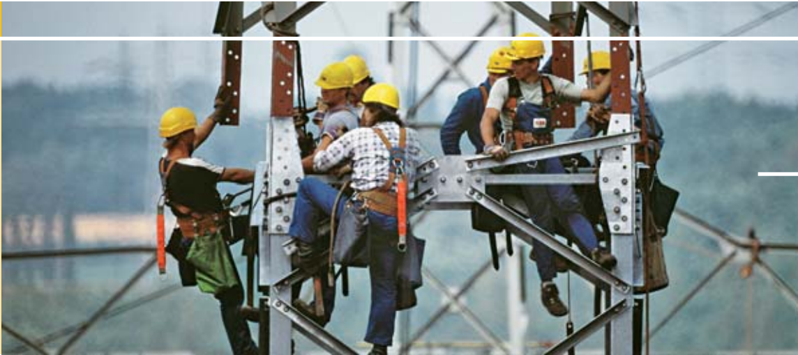
Abb. 24 Arbeiten am Netz der Zukunft. Foto: E.ON Kraftwerke GmbH
